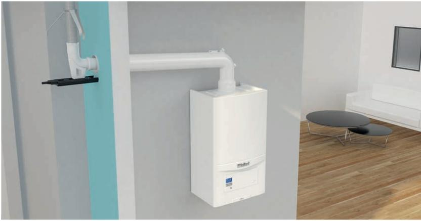
Exemplo de instalação tipo C93 com chaminé colectiva. A conduta flexível de 50 mm leva os gases da combustão da caldeira até à saída, utilizando a chaminé geral para fazer a captação de ar para a combustão.
